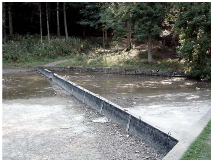
Chevetogne Le déversoir de l'étang 1 et les berges canalisées à la sortie de l'étang 2.
